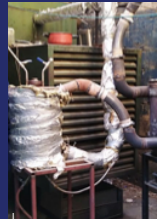
Figure 4 : Premier prototype industriel mis au point encours de test en cas réel sur générateur électrique
