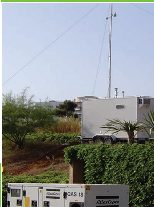
Station mobile installée à la forêt des pins, Beyrouth
